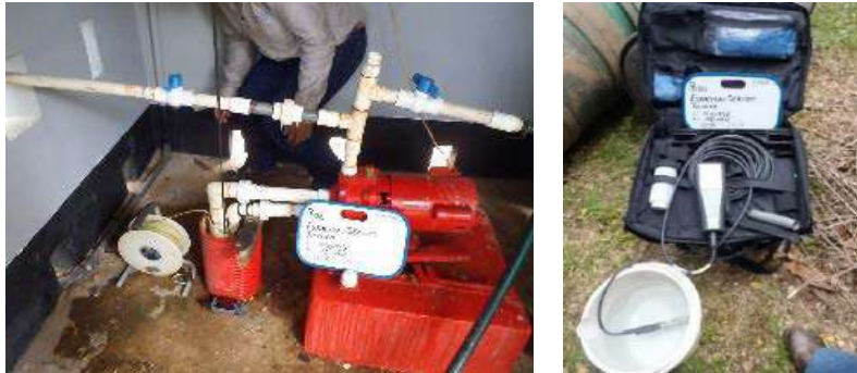
Figura 9-46. Medición in situ con un medidor multiparámetro en un pozo profundo de extracción. Fuente: (CORMACARENA & SIAM S. A., 2016).
