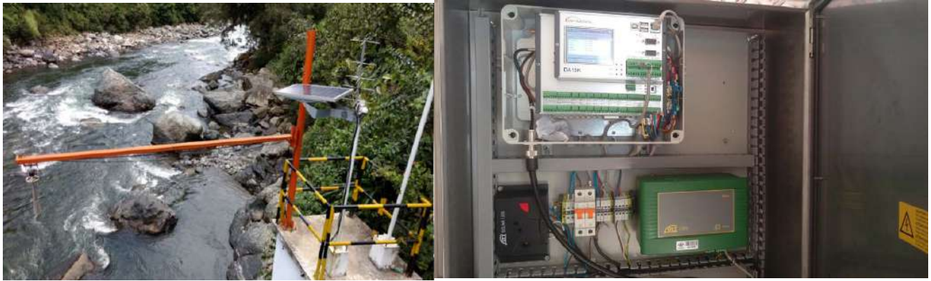
Figura 8-14. Estación limnigráfica digital. Izquierda: Estación satelital Pilispi. Derecha: Estación automática El Banco Magdalena.
