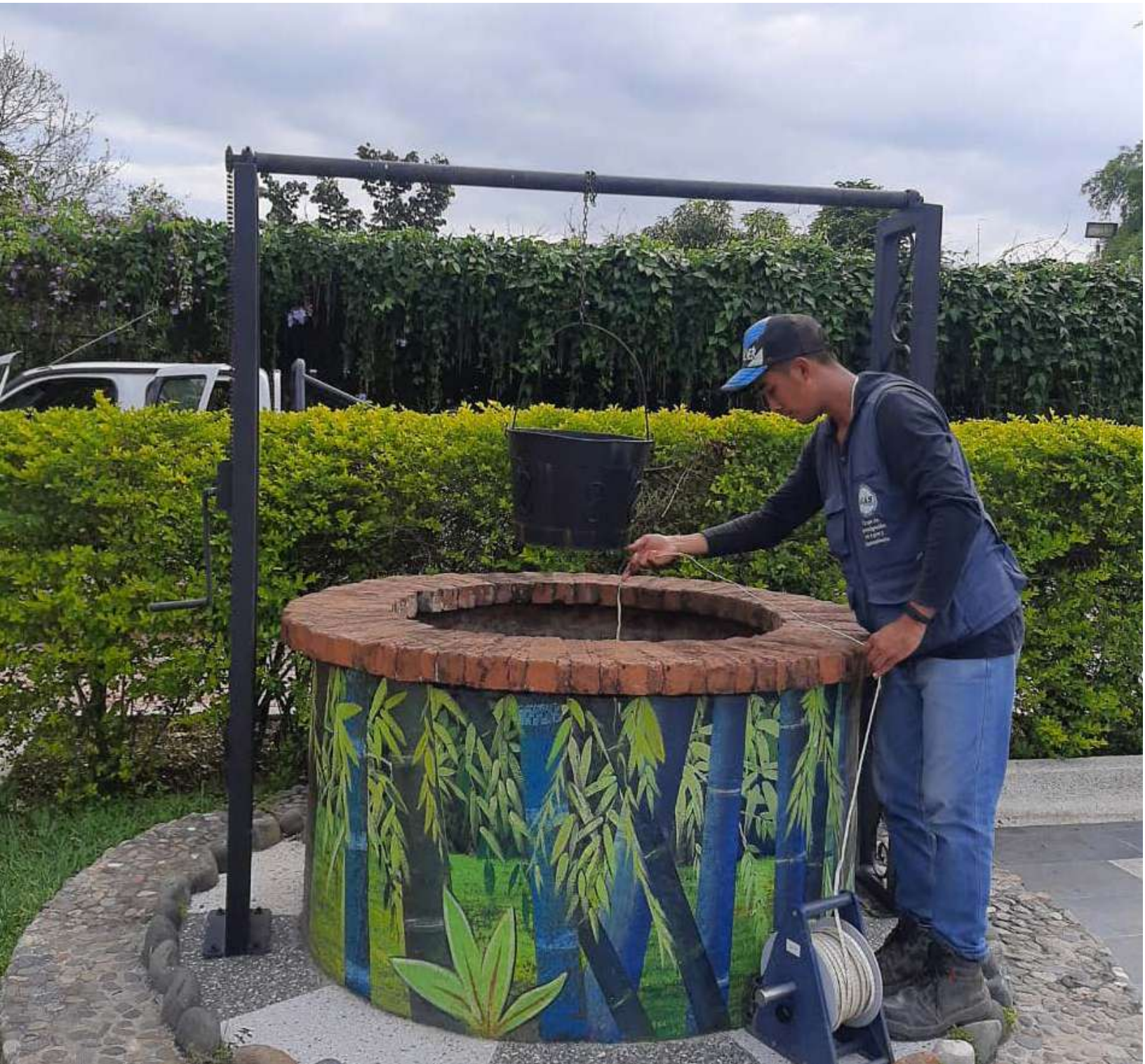
Monitoreo de niveles de aguas subterráneas. Finca La Leyenda, Quimbaya (Quindío)
