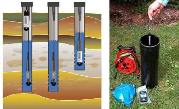
Figura 9-23. Medición de los niveles de agua subterránea utilizando un Diver. Fuente: (Schlumberger Water Services, 2014) (IDEAM, 2015b).
