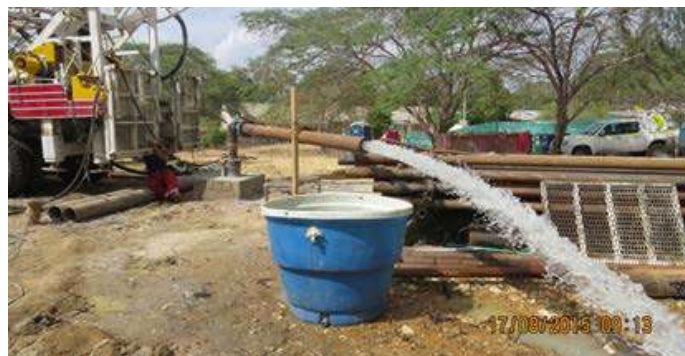
Figura 9-13. Prueba de bombeo a caudal constante Pozo Servicio Geológico Colombiano (SGC) Rihacha 2 (N: 1 765 265, E: 1 132 644). Fuente: (SGC, 2016a).
