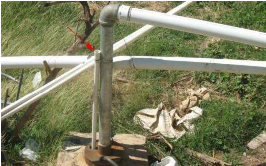
Figura 9-21. Tubería de 3/4 de pulgada de diámetro opcional para las mediciones de niveles con sonda-CORPOCESAR.
