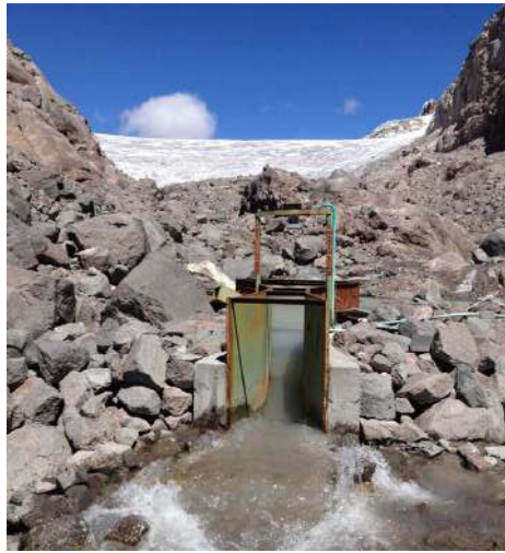
Figura 8-47. Canaleta Parshall Parque Nacional Natural Los Nevados.
