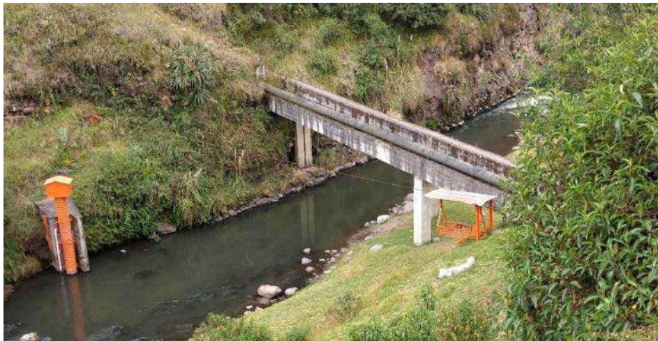
Figura 8-49. Tarabita, Estación Carlosama. Río Blanco.
