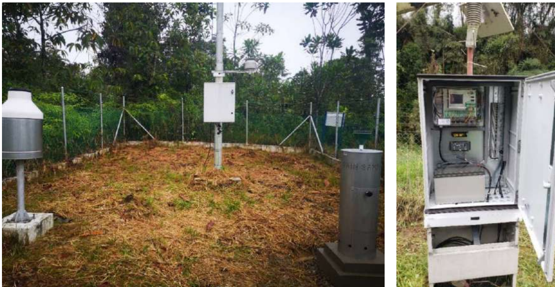
Figura 7-11. Datalogger en estación automática del IDEAM.
