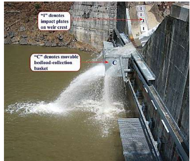
Figura 8-85. Placa de impacto para medir el transporte de carga sólida en la corriente Erlenbach, Suiza (vista lateral de la sección de aguas abajo, con placas visibles en la parte superior derecha y el agua que cae en un tipo de tina). Fuente: (Gray J. et al., 2010).
