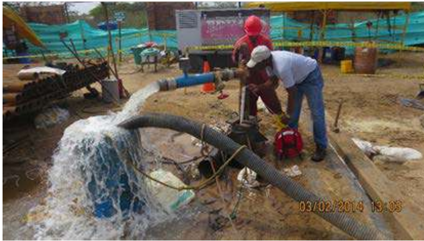
Figura 9-25. Prueba de bombeo a caudal constante pozo SGC Hospital de Maicao. Fuente: (SGC, 2016a).
